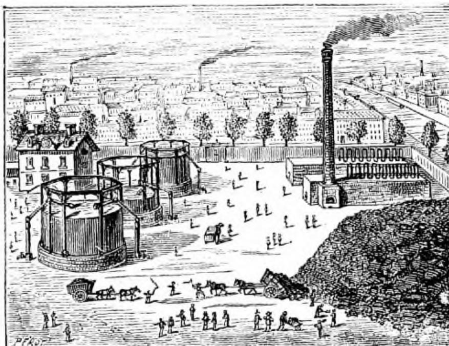
USINE A GAZ – Pour fabriquer le gaz, on enferme la houille dans de grands cylindres de fonte et on la fait chauffer ; le gaz s'en, échappe et, après avoir été purifié, il se rend dans ces espèces de grandes cloches renversées qu'on voit à gauche dans la gravure, e qu'on appelle gazomètres. De ces cloches partent les tuyaux qui conduisent le gaz dans les rues et dans les magasins.
