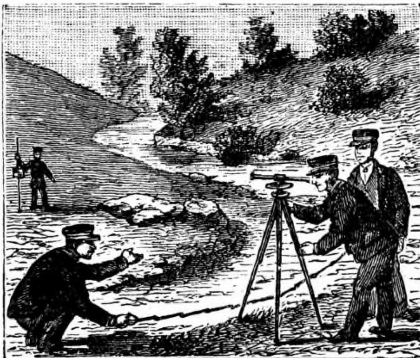
INGENIEURS DES PONTS ET CHAUSSEES DEVANT UN PLAN. – L'ingénieur placé à droite mesure l'élévation du terrain à l'aide d'un instrument appelé *niveau*. Pour cela il regarde à travers cet instrument la *mire* que tient l'homme placé dans le fond, Celui qui est penché vers la terre mesure la superficie du terrain à l'aide d'une longue chaîne dite *chaîne d'arpenteur*.
